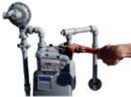
3. Afloje la unión del medidor.
